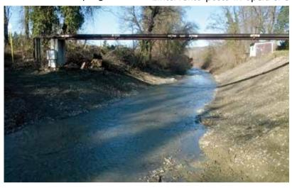
incentrato sulla pulizia dell'alveo da dossi e alberatura che negli anni ne avevano ristretto la sezione, realizzando una mini cassa di espansione. Un intervento in corso di valutazione è la ricostruzione della banchina stradale per proteggere la strada da possibili altre piene.
